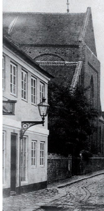
Danmarks første gasværk blev opført i Odense i 1853.
