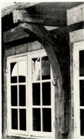
b. Udvendig knægt på Slagtergårdens vestforlængelse, ca. 1525. Fot. TBM 1976.
