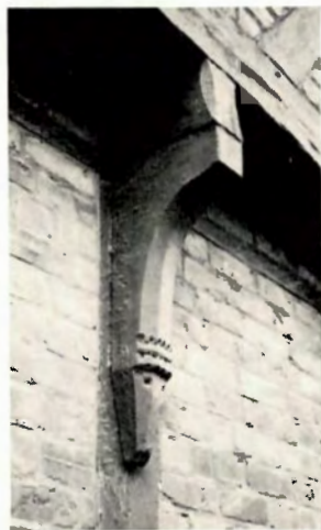
e. Udvendig knægt (med hestehoved forneden) på Pilegrändgårdens hjørnegavlhus i Ystad, ca. 1530. Fot. H.H.E. 1975.
