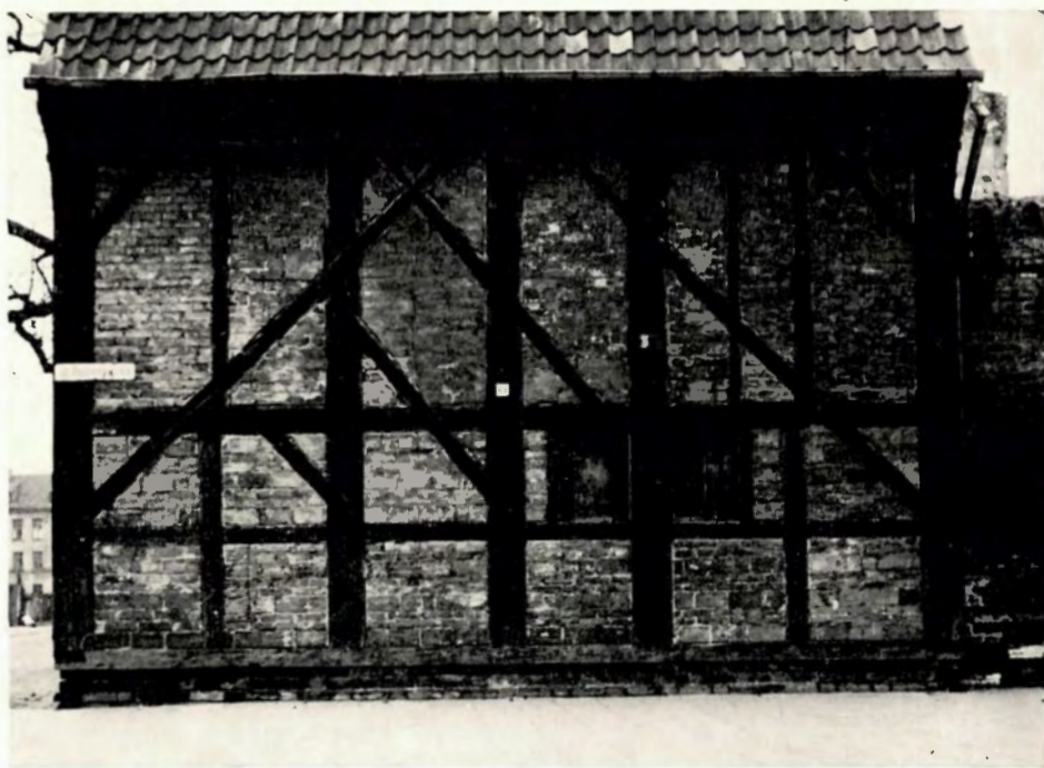
G'Dansk i Polen. Hus ved Katharina kirken afstivet med udvendigt påbladede ranker. Tagudhænget mod gaden støttes af indadsvungne skråstiverknægte med halvrund tværstav på forsiden. Formentlig opført omkr. 1500. Fot. HHE 1965.
