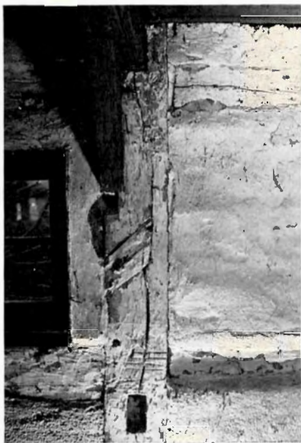
Stolpe 4 (det oprindelige trefagshus' vestre hjørnestolpe) i torvesidens overetage set indefra. Står nu som stolpe 3 fra øst. Bemærk det afskårne svalehaleblad, afbindingsnummeret (fire lange huljærnsstreger) samt taphullet fra gavlens løsholt. Under kopbåndet, der hidrører fra genopstillingen, ses lidt af indsnittet fra gavlranken. Fot. TBM 1975.
