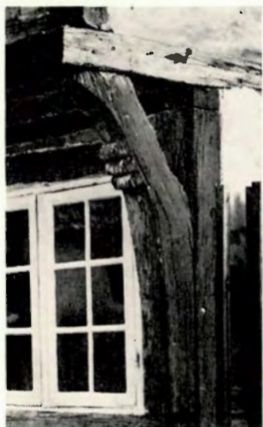
a. Udvendig knægt på Slagtergårdens østre del (træfagshuset), ca. 1500. Fot. TBM 1976.
