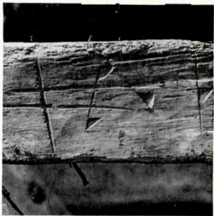
Oprindeligt afbindingsnummer på hanebånd i tagværket. To huljernsstukne streger med lodret tværstreg (bagsidemærkning). Til venstre et yngre afbindingsnummer (tynd streg med to trekanten), hvilket viser, at tagværket er omsat i yngre tid. Hanebåndet er en del af et oprindeligt spær. Fot. TBM 1975.
