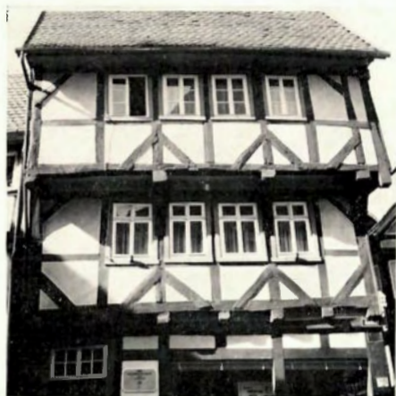
Alsfeld i Hessen, Amthof 8. Hus med korte skråbånd, der er bladede på stolpernes og fodtømmerets ydersider. Stolperne mellem de skråbåndsafstivede stolper er senere indsat. Også løsholterne er af nyere dato, idet de har afløst gennemløbende sidebånd, der var bladede over stolpernes forsider. Opførelsestid omkr. 1400. Fot. HHE 1970.
