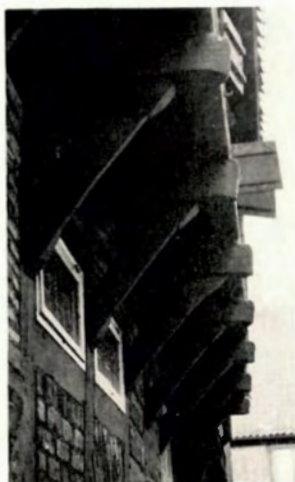
d. Udvendige skråstiverknægte på Pilegrändgårdens magasinbygning i Ystad, ca. 1490-1500. Fot. H.H.E. 1975.
