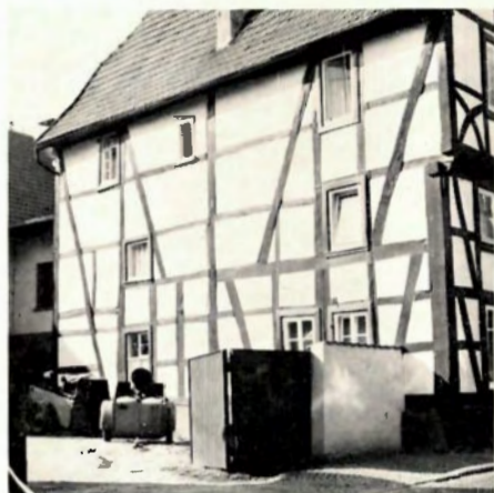
Alsfeld i Hessen, Hersfelder Str. 15. Gavlhushus med fire lange udvendige ranker i langsiderne. De tre forreste ranker har oprindeligt haft samme længde som den bageste. Opførelsestid omkr. 1450–1500. Fot. HHE 1970.
