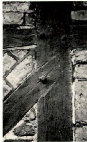
f. Kort skråbånd fastgjort i stolpe og fodrem med hageblad. Pilegrändgårdens magasinbygning, ca. 1490-1500. Fot. H.H.E.
