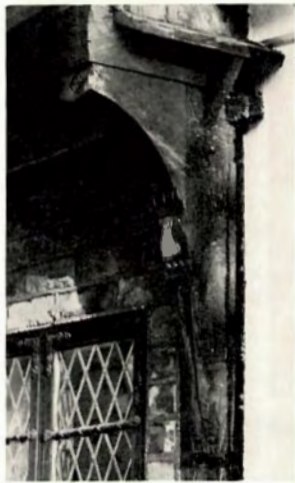
c. Udvendig knægt på St. Kirkestræde 20, opført 1527 (delvis rekonstrueret). Fot. TBM 1976.
