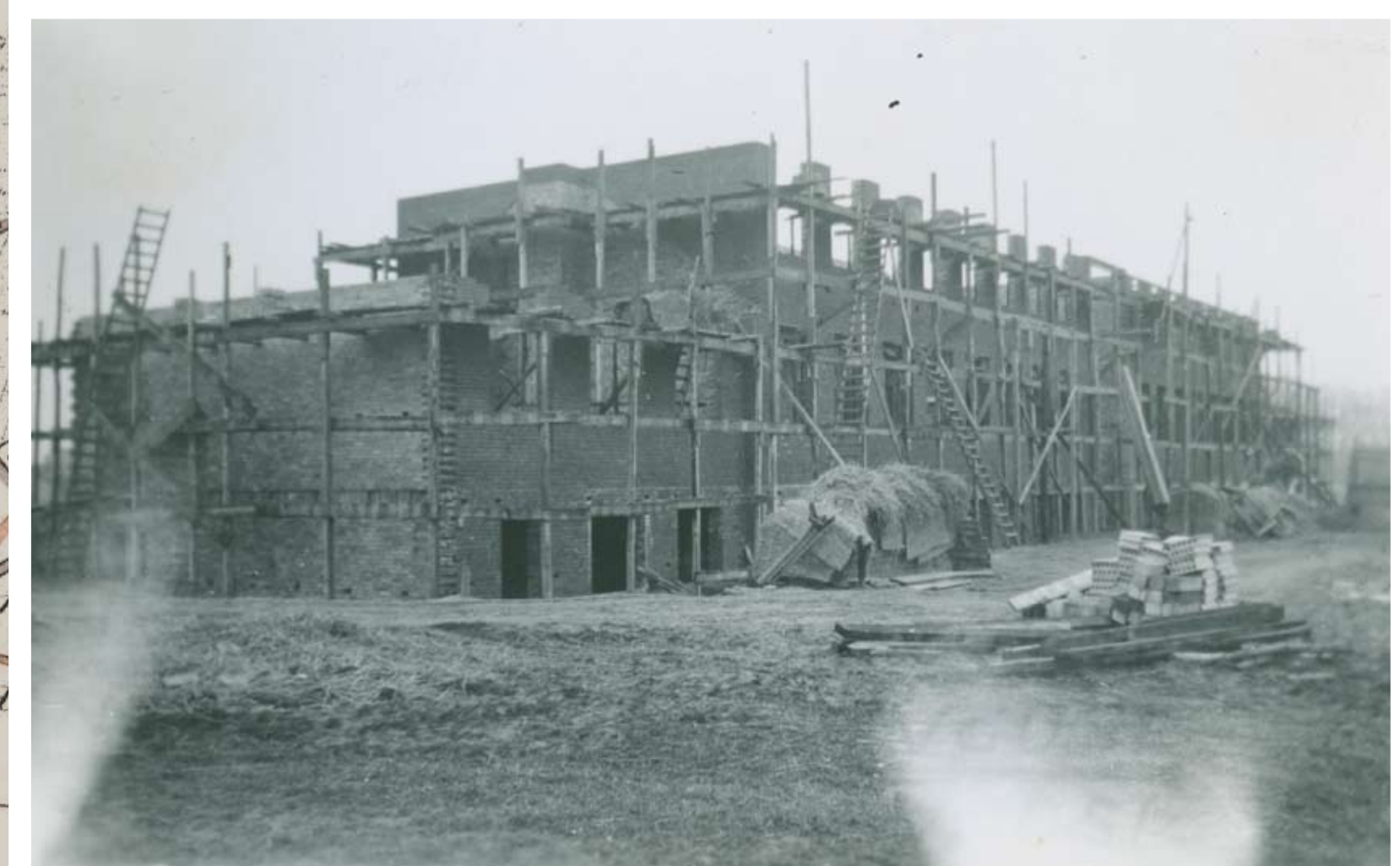
Herfølge Skole under opførelse. Hovedbygningen, vinteren 1953.
