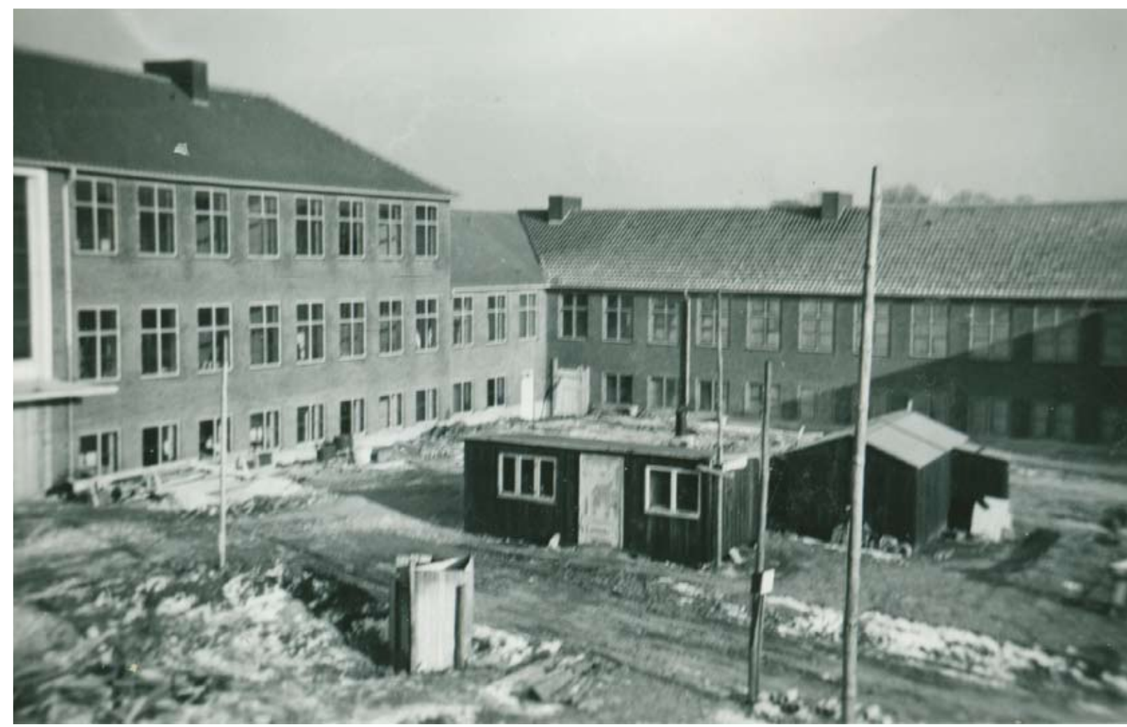
Byggeplads midt i skolegården.
